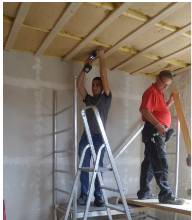
Wand- und Deckensanierung in der Lindenstraße
