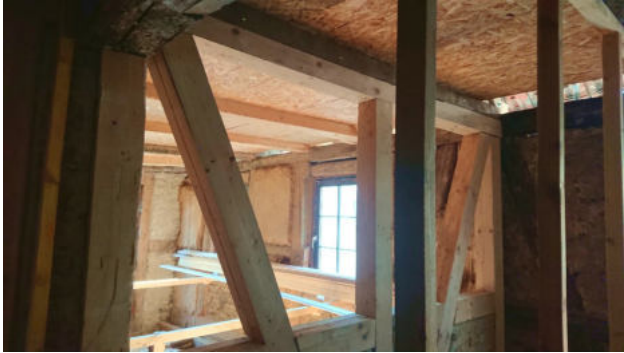
Tragfähige Fachwerkwände stabilisieren das Haus von innen.
